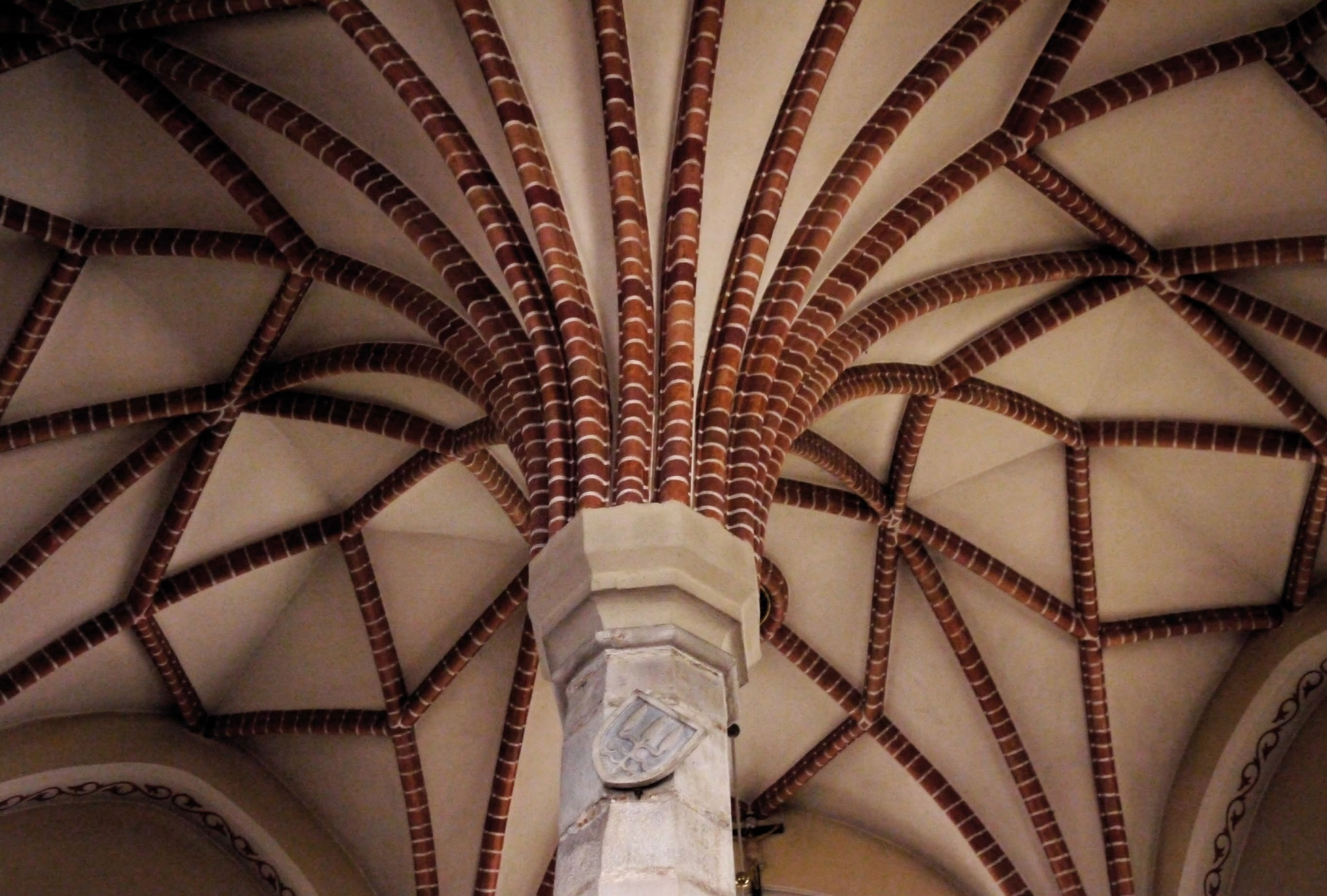
Gosławice - sklepienie z herbem Godziemba.
